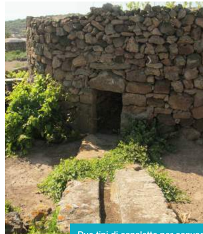
Due tipi di canalette per convogliare l'acqua all'interno del giardino.
